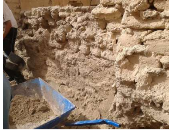
شكل رقم (46) صورة لتنظيف الجدار و الحقن بملاط عالي السيولة
