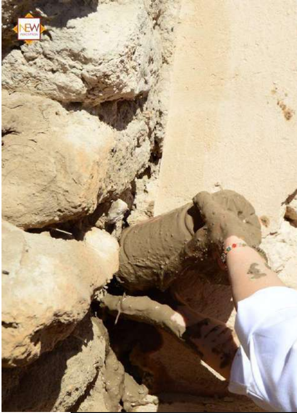
شكل رقم (46) صورة لتنظيف الجدار و الحقن بملاط عالي السيولة
