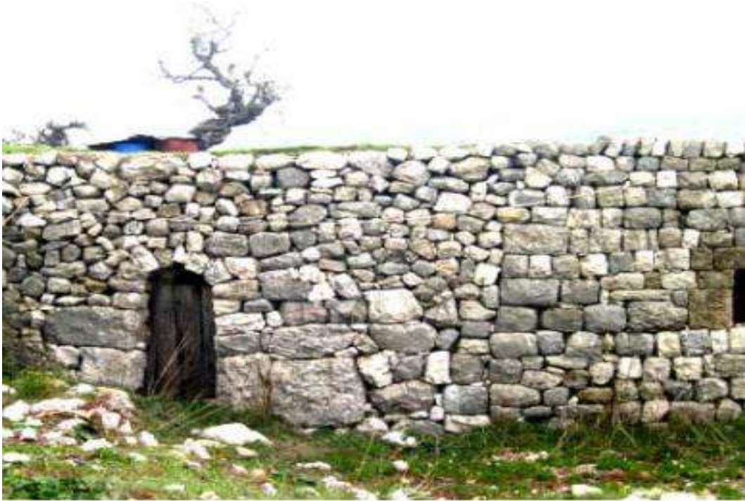
شكل رقم (08) صورة عامة لجدار مبني من الحجارة و الملاط
