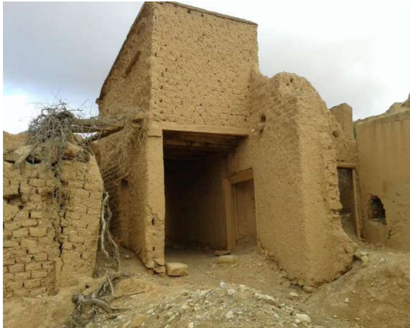
شكل رقم (05) صورة لمبنى صحراوي
