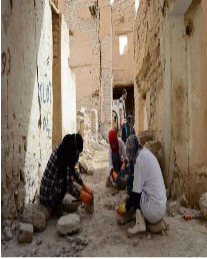
شكل رقم (44) صورة لجلب الطوب المستعمل وتنظيفه
