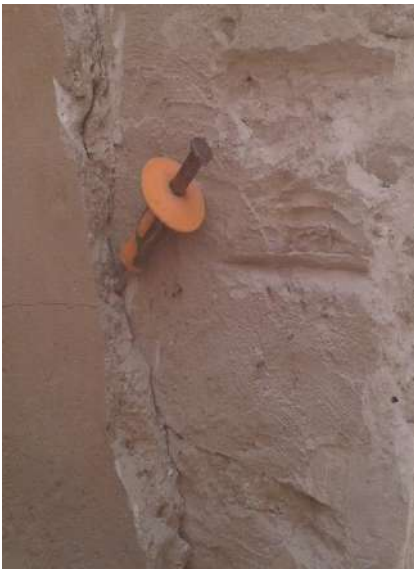
شكل رقم (49) صورة توضح تقشير التلبيس القديم
