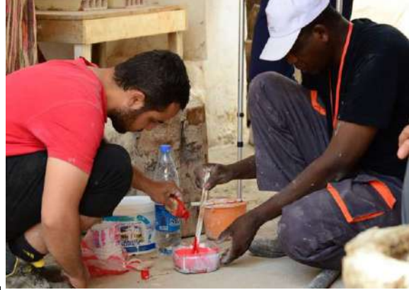
شكل رقم (53) صورة توضح تحضير الجير و الصبغة
