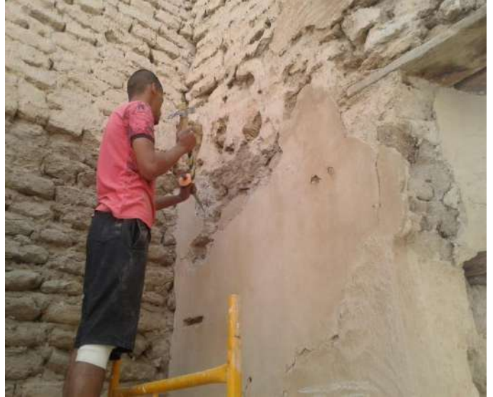
شكل رقم (49) صورة توضح تقشير التلبيس القديم
