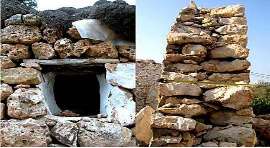
شكل رقم (12) تقنية وضع الحجارة
