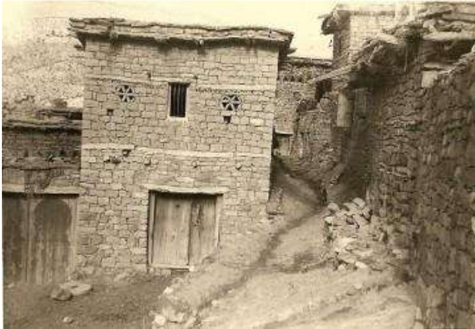
شكل رقم (02) صورة لمبنى ريفي بطابقين
