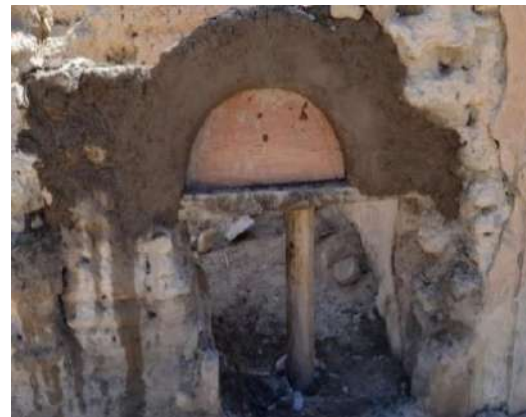
شكل رقم (51) صورة توضح كيفية بناء قوس
