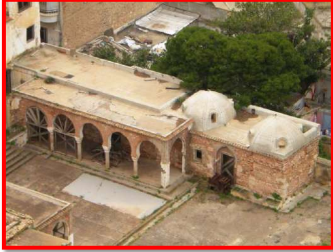
الحمام الملحق بقصر الباي بوهراڻ (النمط الثالث)
